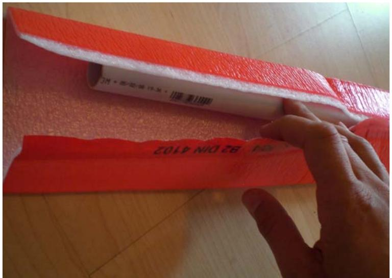
Den Schlauch aufzutrennen empfiehlt sich, da man ihn dann besser und mit weniger Faltenbildung gleichmäßig um das Plastikrohr wickeln kann.
