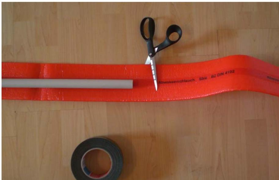
Schiebt dann das Rohr in den abgeschnittenen Dämmschlauch hinein.
