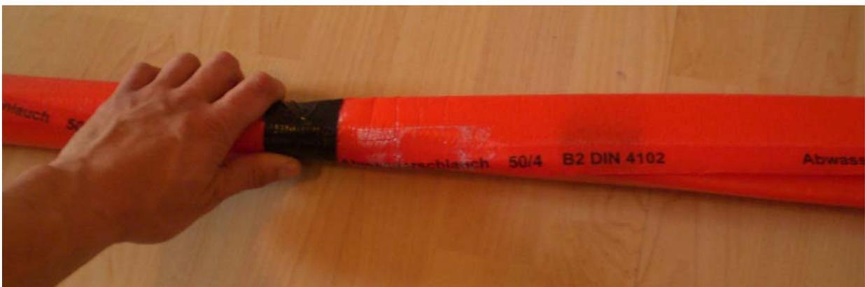
Anschließend wird das Dämmmaterial feste um das Plastikrohr gewickelt und mit dem vorbereiteten Klebeband befestigt.
