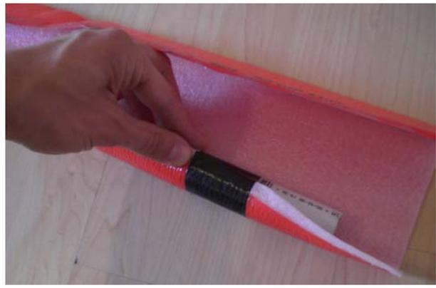
Fixiert nun die eine Seite der Dämmung mit dem Klebestreifen am Plastikrohr.
